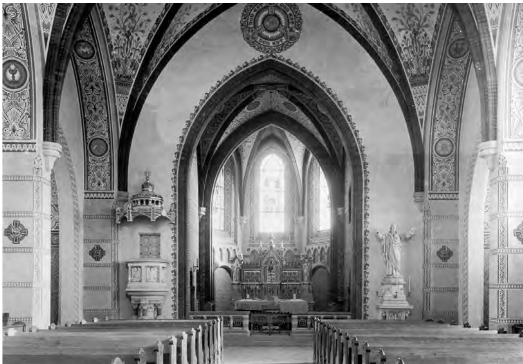
Die neue Pfarrkirche
